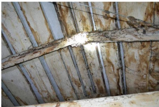
Foto.nr.17-60. Alcătuirea planșeului de pod și șarpantei acoperișului.
