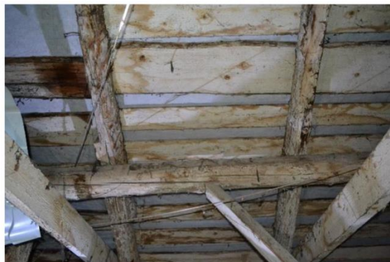
Foto.nr.17-60. Alcătuirea planșeului de pod și șarpantei acoperișului.
