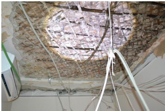
Foto.nr.17-60. Alcătuirea planșeului de pod și șarpantei acoperișului.
