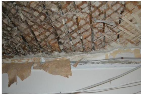
Foto.nr.17-60. Alcătuirea planșeului de pod și șarpantei acoperișului.
